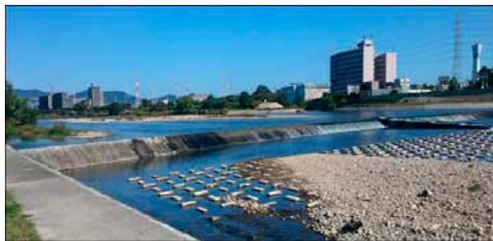
図2. 固定堰 (地点3 撮影日 2016.10.24)
