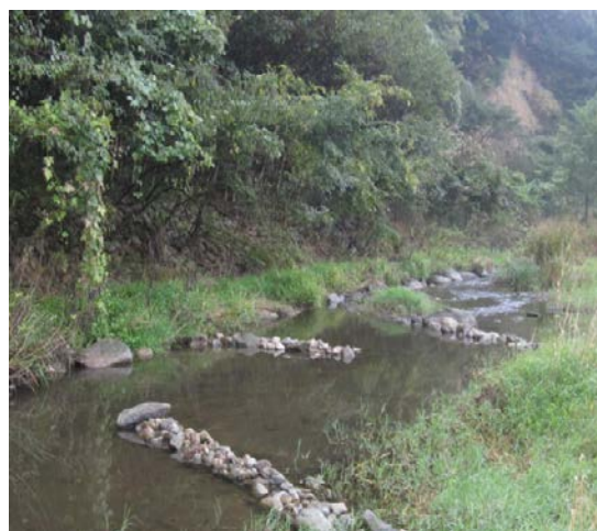
写真6、川づくり作業 完成
