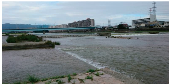
図3. 可動堰 (地点5 撮影日 2016.9.30)
