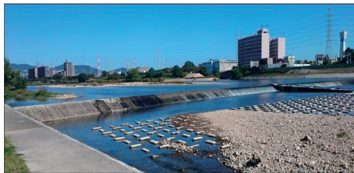
図2. 固定堰 (地点3 撮影日 2016.10.24)
