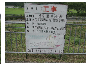
図4 河川工事(B地点)
