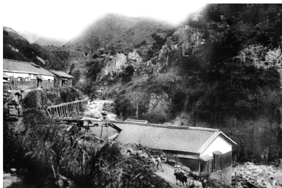
かつての八幡場の水車場（現在の住吉霊園の下）長い「とゆ」を流れて屋根に突き刺さるように水が落ちます。※神戸大学所蔵「御影の里 写真集」より転載
