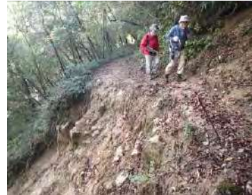
台風で崩壊した山道
