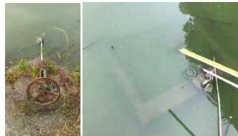
図10 斜樋(左)と土砂吐ゲート(右)
