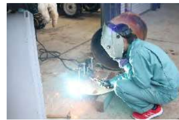
図6 窯用ドラム缶を溶接
