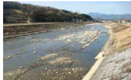
津山市高尾皿川河床 越流堰が降ろされ水が引いた状態
