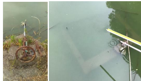
図10 斜樋(左)と土砂吐ゲート(右)
