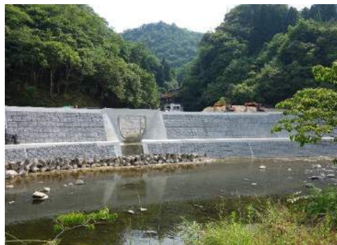
写真5 武田尾地区の工事後
