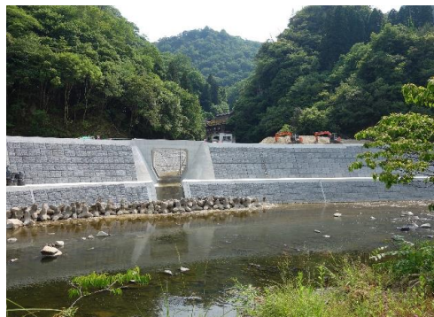
写真5 武田尾地区の工事後
