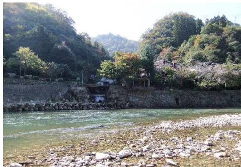
写真4 武田尾地区の工事前
