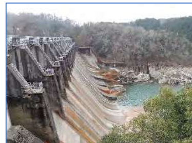
写真11. 大井ダム。写真の左に恵那峡、右下に発電所がある。
