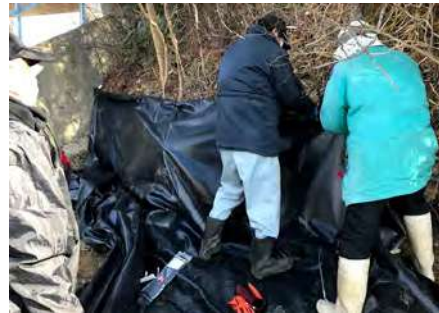
図 7. 遮光シートを設置する様子
