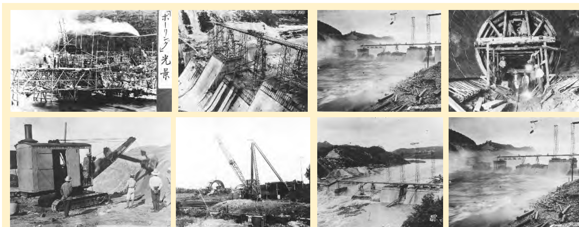
写真 12~19. 大井ダム建造工事の様子 (画像提供: 土木学会附属土木図書館)
