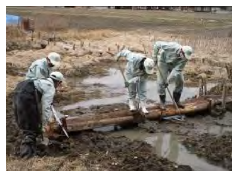
写真5 栈橋の設置
