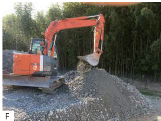
図 3 川代第 1 トンネル岩砕を対象とした石割調査の手順. A. 化石を含有すると推定される岩石を探す. B. 調査対象の岩石の表面を肉眼もしくはルーペで観察し化石の有無を確認. C. ハンマーで岩石を割り、破断面で化石の有無を確認. D. 化石らしきものが見られた場合、研究員に化石か否かを再確認. E. 表面に化石が見られない岩石は調査済みとして処理. F. 重機を用いた篩いによる岩砕の選別.
