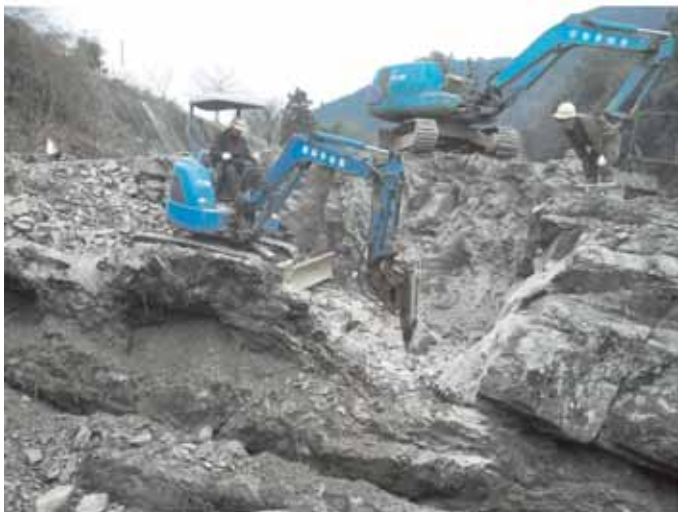
重機による掘削作業
