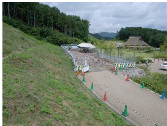
法面直下の調査エリア
