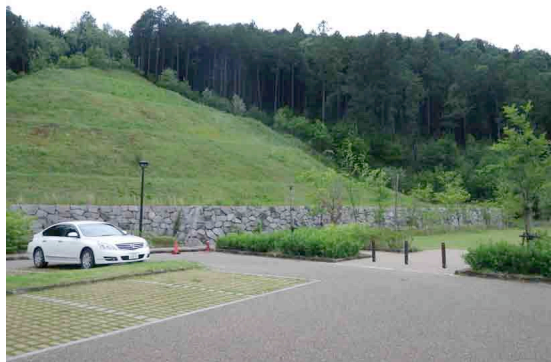
化石が発見された法面
