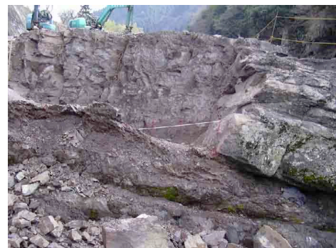
上流対岸側に約30度傾斜する地層
